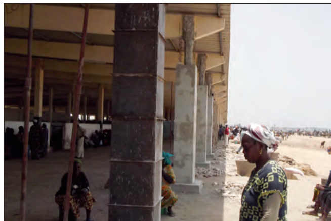
Poteaux refectionnés par le projet
