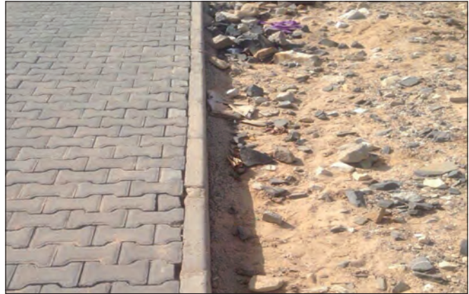
Prémices de dégradation des bordures de l'allée
