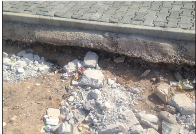
Prémices de dégradation des bordures de l'allée
