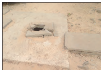
Fosse septique en dégradation
