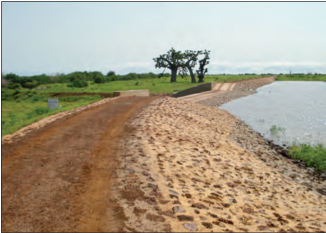
Crête et pentes d'une digue en terre bien protégées par de la latérite de bonne qualité et moellons maçonnés
