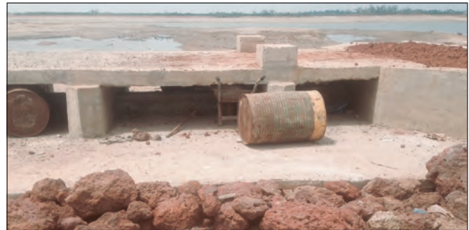
Obstacle au droit de l'évacuateur
