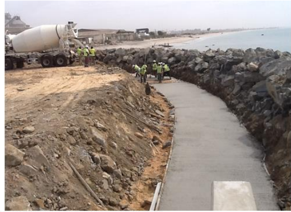
DIFFERENTES PHASES DE CONSTRUCTION DU MUR DE SOUTÈNEMENT
