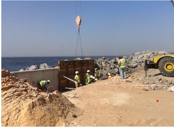
DIFFERENTES PHASES DE CONSTRUCTION DU MUR DE SOUTÈNEMENT
