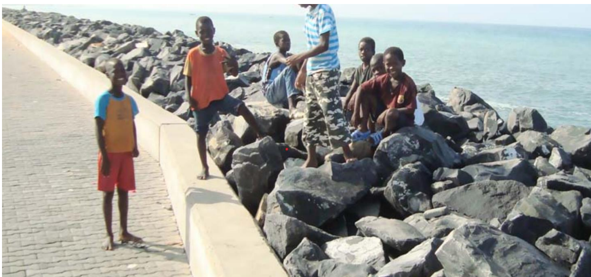
Digue achevée avec sa promenade
