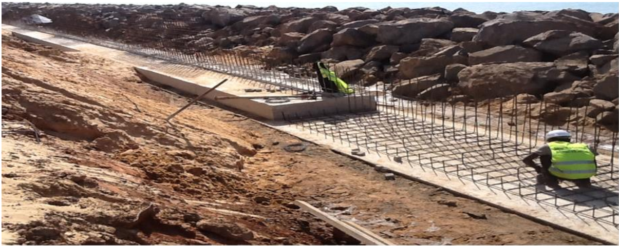
FONDATION DU MUR DE SOUTÈNEMENT : FERRAILLAGE ET COULAGE DU RADIER
