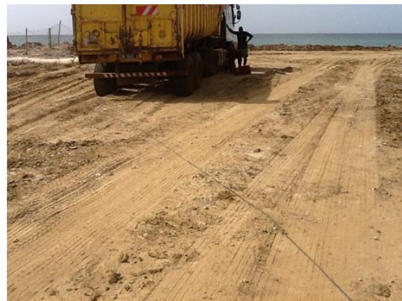
POURSUITE REMBLAI LE LONG DE LA DIGUE
