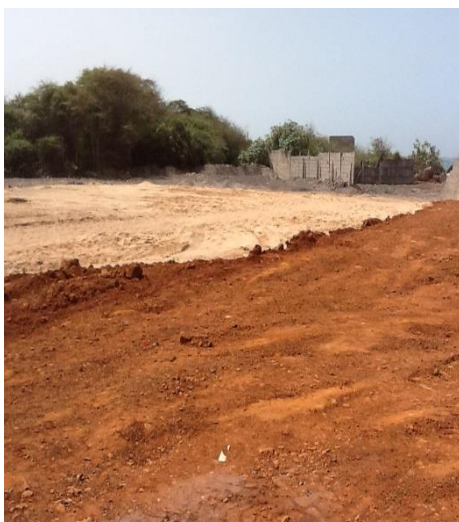
Aire de stockage des matériaux
