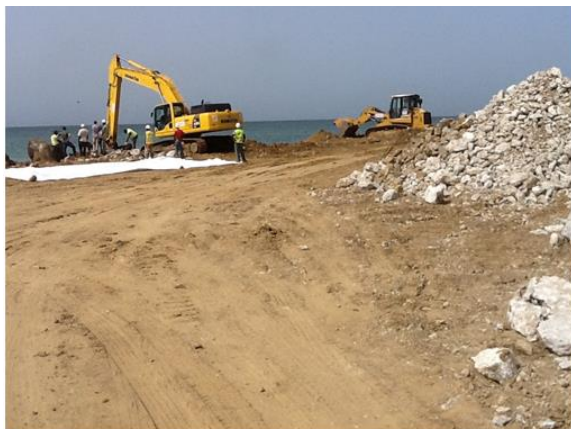
REMBLAI ET PRÉPARATION POSE GEOTEXTILE
