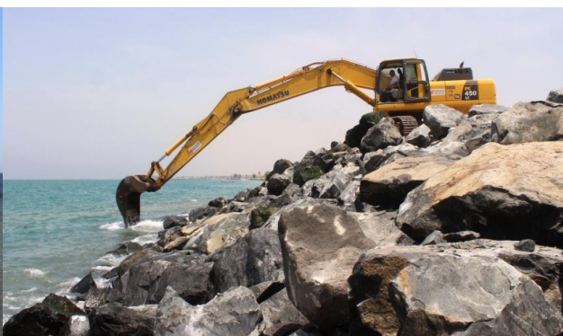
Pose d'enrochement de 2 à 4 Tonnes
