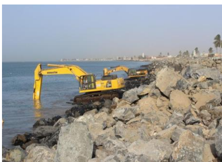
Déblai et profilage du terrain naturel
