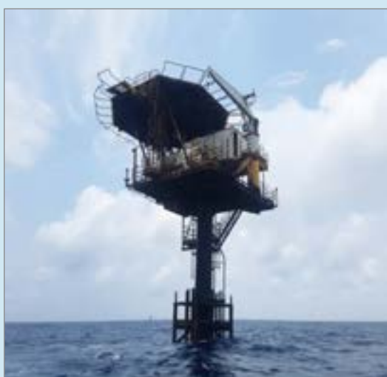
Aperçu de la plateforme pétrolière abandonnée à Sèmè-Kpodji (Koumba et al, 2019)
