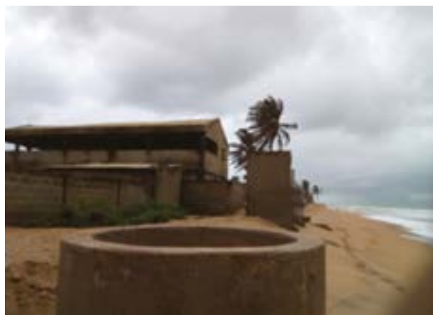
Un puits désormais exposé aux vagues parce que l'habitation dans laquelle elle était est détruite
