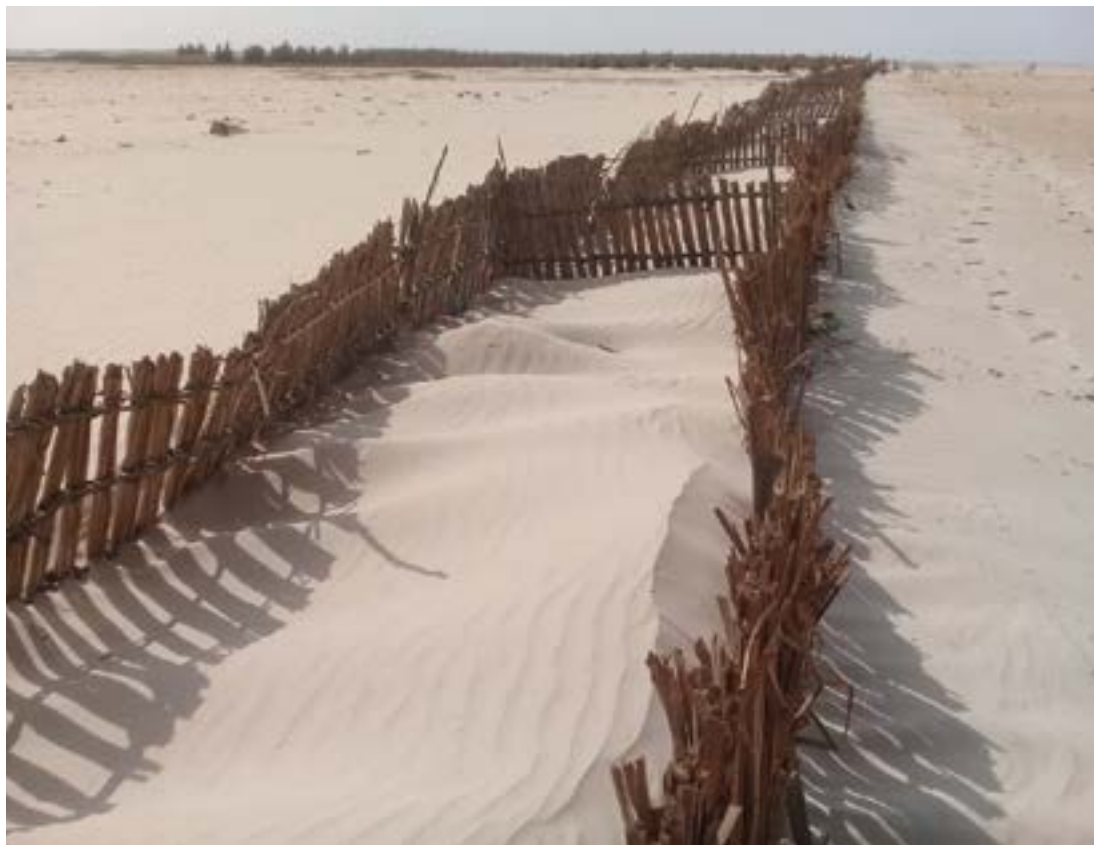
Mise en place de palissade de Typha australis (typhavelles) pour fixer les dunes côtières de la Langue de Barbarie dans l'AMP de Saint-Louis (WACA FFEM)
