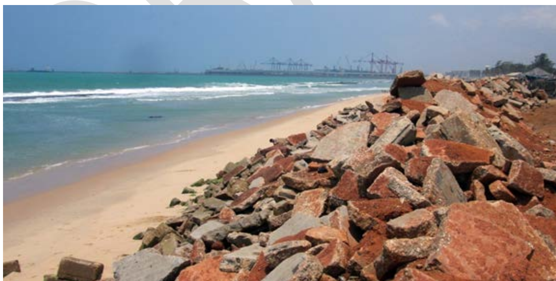
Dépôt de blocs de gravats en aval du port de Lomé - Source antenne nationale MOLOA Togo.
