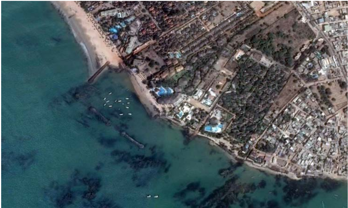
Aménagement anti érosif se traduisant par une érosion accrue et intense au niveau du secteur d'habitat traditionnel situé en bas à droite de l'image
