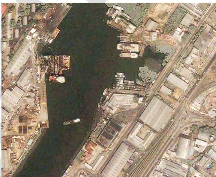
Zones industrielles, infrastructures portuaires, etc...
