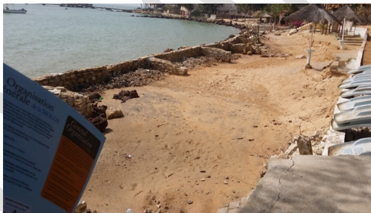
Mur de protection de la plage à Saly niakh Niakhal
