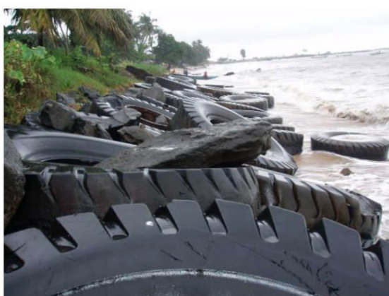
Protection à base de pneus de tracteurs et de blocs à Buchanan (source antenne nationale Liberia)
