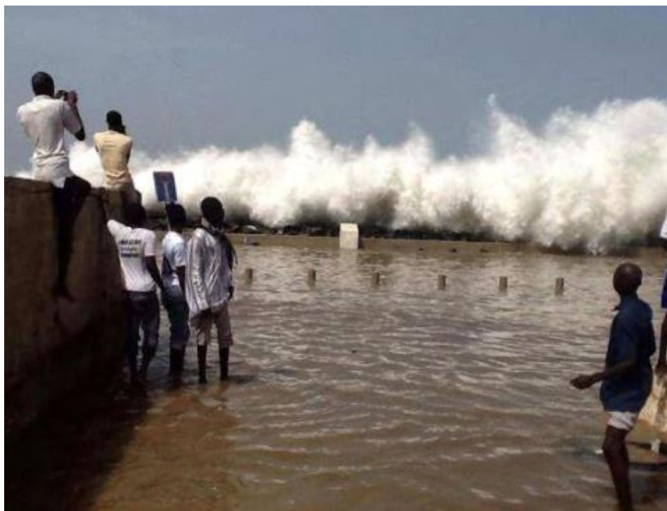
Déferlement des vagues au niveau de Rufisque – Sénégal (Digue de protection de Thiawllène)
