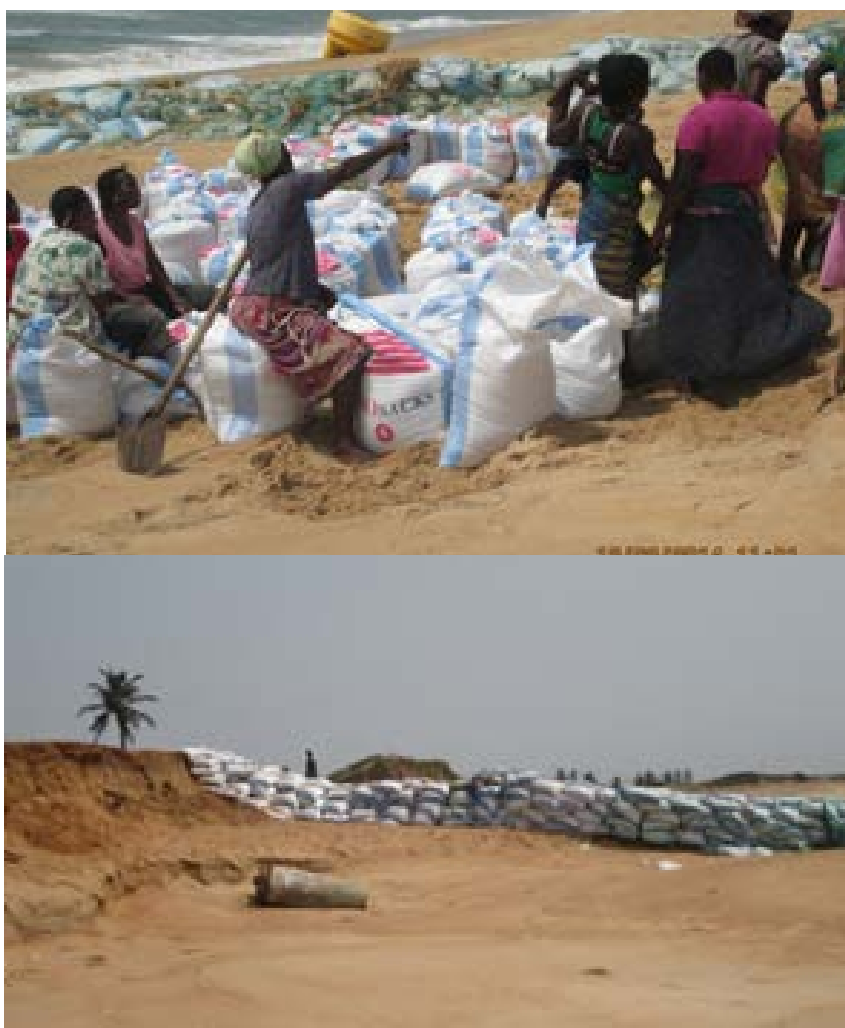
Protection à l'aide de sacs de sable - Source antenne nationale MOLOA Togo.
