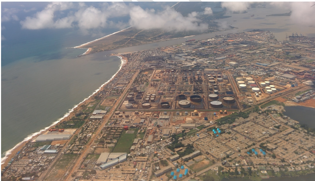
Vue aérienne d'une partie du port d'Abidjan et du Canal de Vidri
