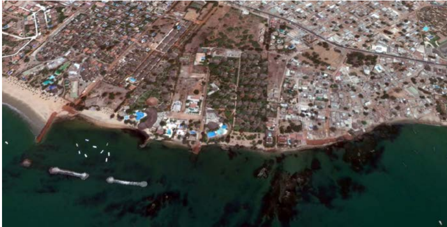
Aménagements de protection à Saly Sénégal. Le village situé en aval de la dérive littorale (sur la droite) subit les effets du déficit sédimentaire consécutif aux aménagements de l'hôtel
